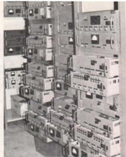
PHOTO E: Salle des émetteurs VHF située de l'autre côté de la piste. Il n'existe, au service contrôle aérien, que la B.F. que l'on pourrait schématiquement représenter par un microphone et un haut-parleur. Toute la partie émission et réception est disposée près de la piste, dans deux bâtiments espacés de 2 km pour éviter les interférences. Les émetteurs représentés sur la photo sont en train d'être réformés et seront bientôt remplacés par des ensembles à transistors.
